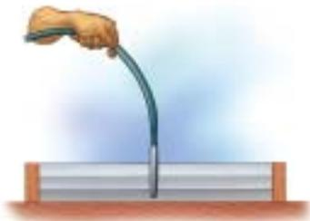
El vibrador debe ser lo suficientemente largo para penetrar en la capa inferior
