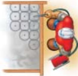
El vibrador debe ser lo suficientemente largo para alcanzar y entrar hasta las capas de concreto por debajo de la que se está compactando.
