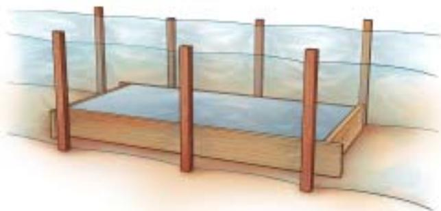
ROCÍE el concreto con “alcohol alifático”\* después del acabado inicial, lo que reducirá la EVAPORACIÓN y el AGRIETAMIENTO.
