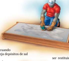
Causas A veces hay sales minerales disueltas en el agua. El agua con sales minerales disueltas se acumula en la superficie de concreto, cuando el agua se evapora, deja depósitos de sal en la superficie.
