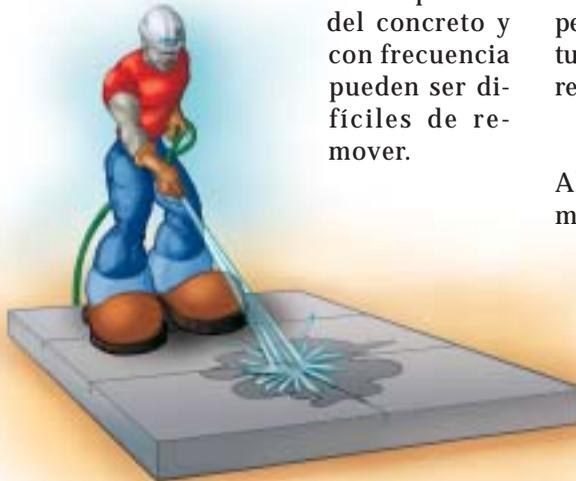
no se puede remover químicamente, puede ser sopleteada con arena. Esto remueve la superficie del concreto y puede exponer los agregados.
